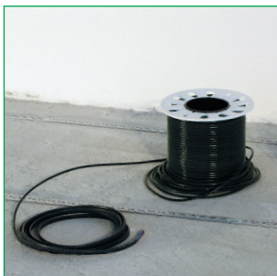
▲ Монтажная лента уложена
