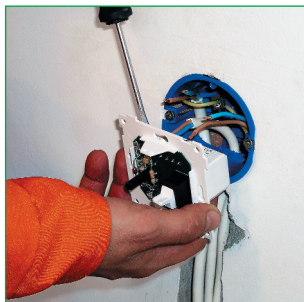
▲ Подключение терморегулятора
