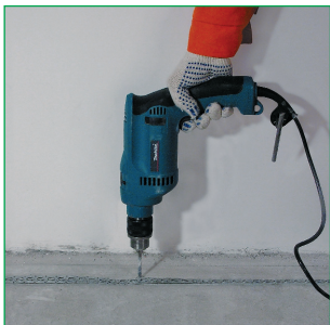
▲ Просверлить отверстие
